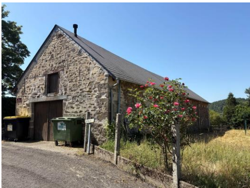
Exemple de grange susceptible de changer de destination
